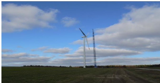
Výstavba elektrárny Drahaný (Zdroj: Eldaco a.s.)
