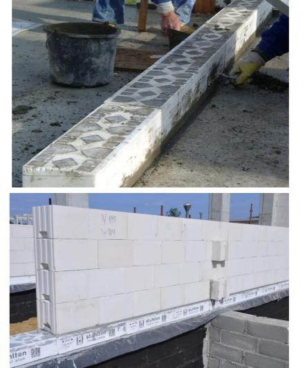
rys 2. Cokół izolowany: zamknięcie pasa izolacji i eliminacja mostka cieplnego
