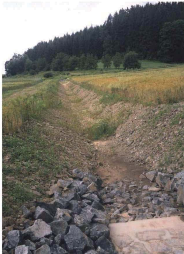
Foto č. 2: Svodný příkop Na kyselém (k.ú. Sloup).
